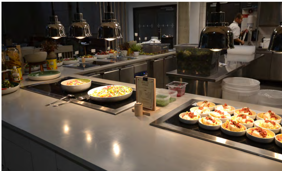
Varmeplater for nedfelling og Stayhot varmelamper. Kjølebenker under.
